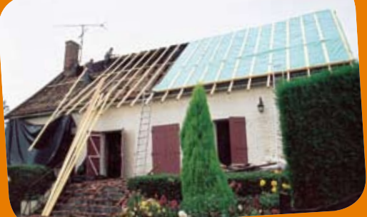
Pose de bâches en mesures conservatoires
